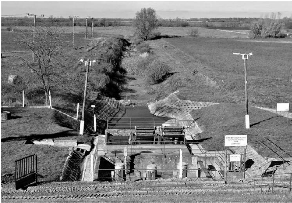
6. kép – A Tőkefoki-szivattyútelep, 2015. július (Fotó. Oláh F.)
