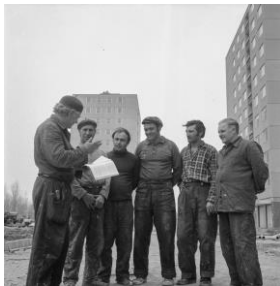
5. kép: Épülő Szeged-Felsővárosi panelházak 1980-ból
